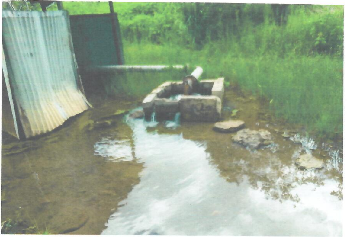
Source de captage d'eau
